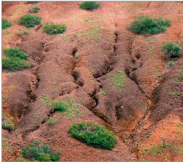
Figura 27 | Erosão do solo.
